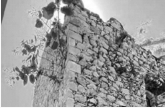
FIG. 15. INCIDENCIA A LA LUZ SOLAR DE INMUEBLE. FUENTE: CATÁLOGO PHASE CERO
