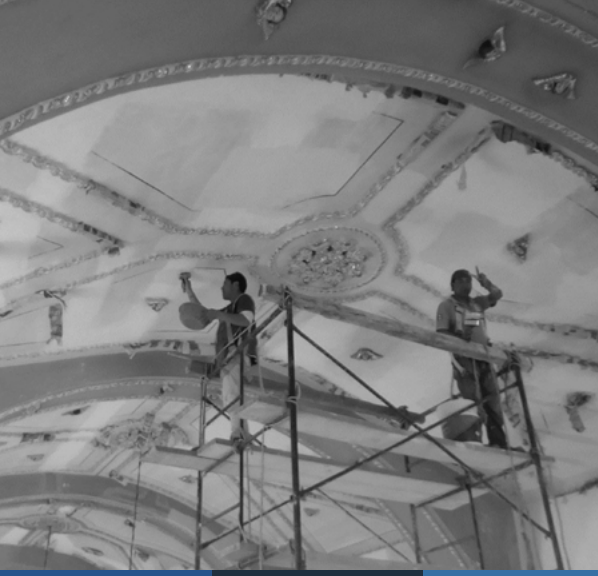
FIG. 19. TRABAJOS DE MANTENIMIENTO EN BÓVEDA DE NAVE PRINCIPAL, TEMPLO DE SAN LORENZO MARTIR, TOCHTEPEC, PUEBLA. FUENTE: CATÁLOGO PHASE CERO
